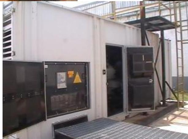
Generador Himoinsa. HTW-1025 T6; 1281 KVA; 1025 KW, 1800 RPM, 480/277 V, 60 HZ. Motor Mitsubishi S12H PTA Diésel, turboalimentado y post-enfriado.
